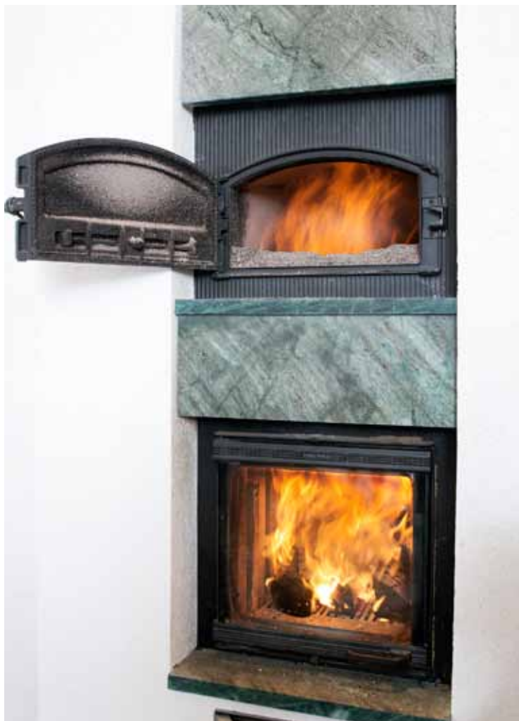
Heikki Hyytiäinen on kehittänyt vähäpäästöisen leivinuunin, jossa puut palavat tulisijan alaosassa erityisessä tulipesässä, ja liekit lämmittävät leivinpesän, joka ei nokeennu.
